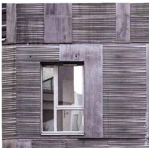
▲ À partir de ciment conçu pour une grande résilience, le béton élaboré pour les façades de cet immeuble de logements à Paris (17 e arr.) de Thibault Robert Architectes et Associés est multioptionnel : autonettoyant, coloré en noir, matricé, architectonique et autoplaçant.
