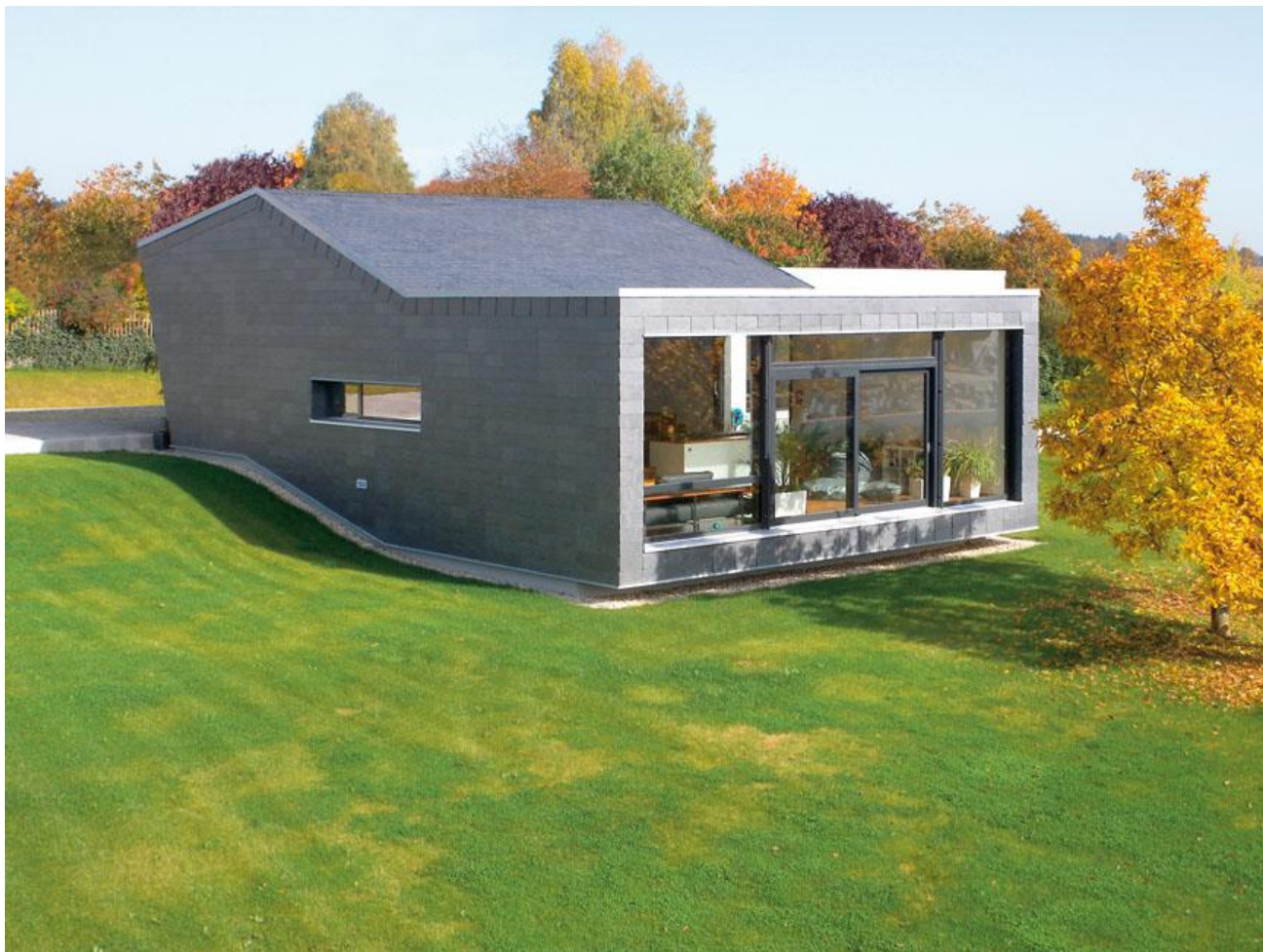
Une villa ultra contemporaine entièrement protégée d'ardoises naturelles. Fédération des Professionnels de l'Ardoise Naturelle . © FPAN
